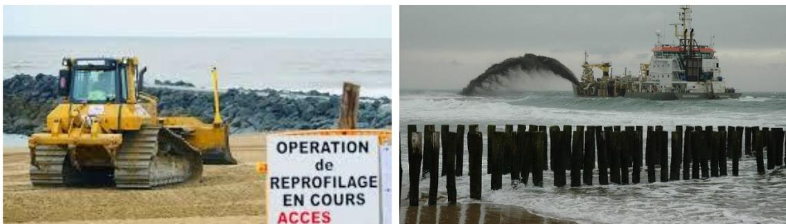
Figure 11. Photographie d'un reprofilage à gauche et d'un rechargement par « rainbowing » à droite.
