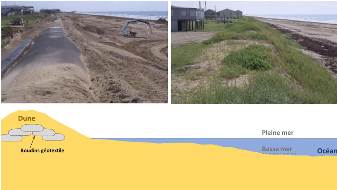
Figure 27. Photos et coupe type schématique d'une solution noyau Géotubes
