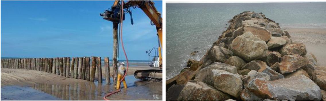
Figure 8. Exemple d'épi en bois sans bardage à gauche et en enrochements à droite.
