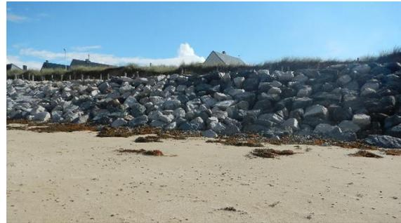
Figure 14. Exemple de perré en enrochement à St Germy / Ay
