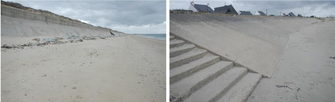
Figure 22. Exemple de perré en béton à Gâvres
